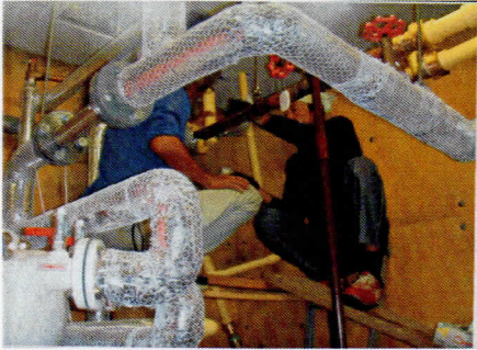
撮影項目 宿毛育成園給湯設備改修工事 ボイラー室露出給湯ポリブデン配管状況
