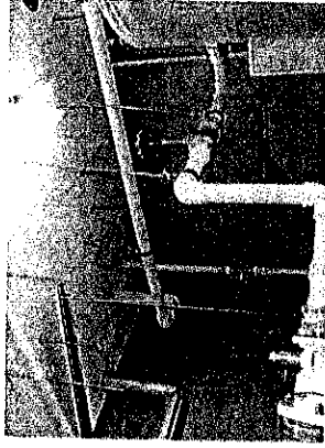
撮影項目 宿毛青成園ボイラー室 給湯配管改修工事 ボイラー室給湯設備改修 及び配管支持
